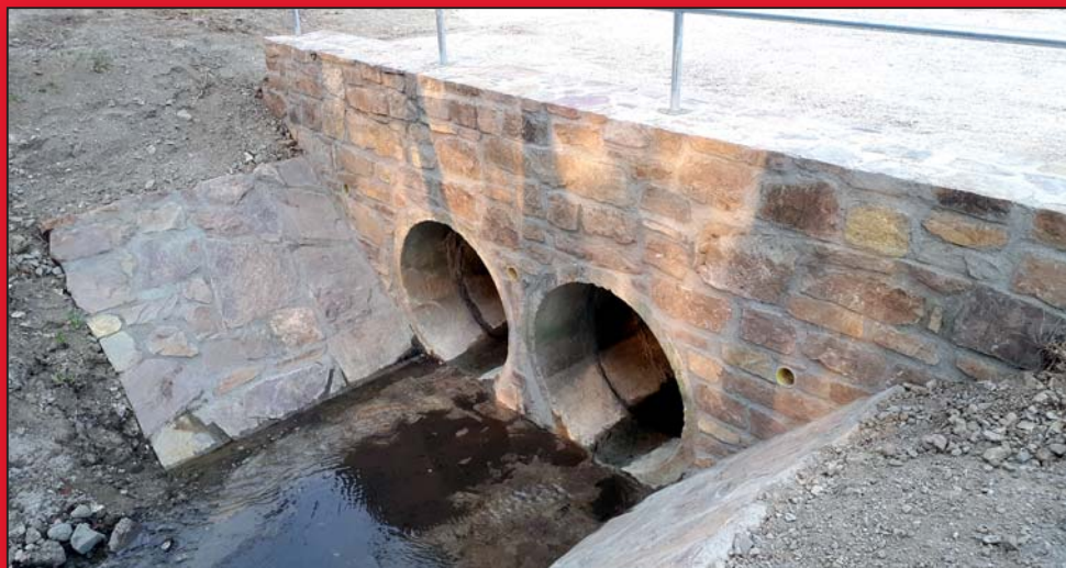
Nově opravený propustek
