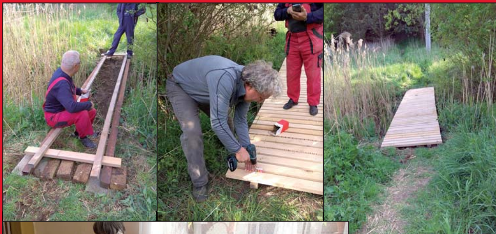
▲ SDH opravuje mostek přes potok
