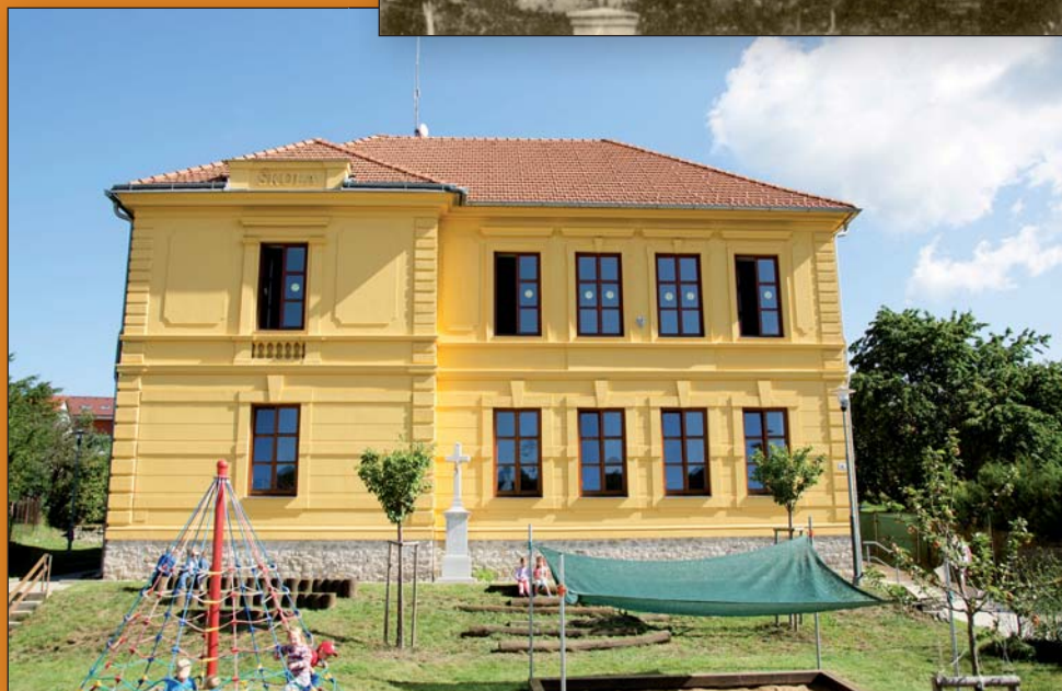
Budova školy dnes
